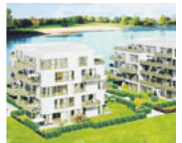
Grosse plant den Bau von 45 neuen Wohnungen in der Überseestadt. Grafik: Justus Grosse
